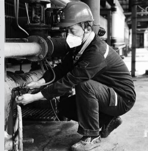
4月份，焙烧炉流化床冷却器因管内结垢堵塞严重进入了清洗检修期。焙烧炉流化床冷却器作为热交换系统，单个冷却单元结构由12组立管连通17组横管组成，形成了一个204根横管交织在一起的“大网”，要想逐一清洗到位费工又费时。
