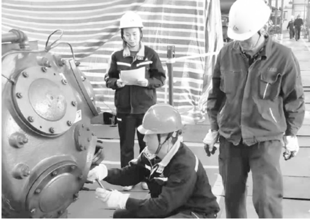
运行维护中心空压维修工正在拆卸卸压阀盖。 宁许辉 摄影报道
