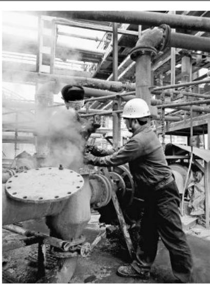
近日,第二氧化铝厂溶出区域秉承提高设备运转率就是最大降本增效的原则,积极组织员工开展设备维护工作,把设备隐患消灭在萌芽状态,把检修设备的影响缩至最小范围。图为沉降片区员工正在清理沉降公底流C泵除渣箱。王敬宇摄
