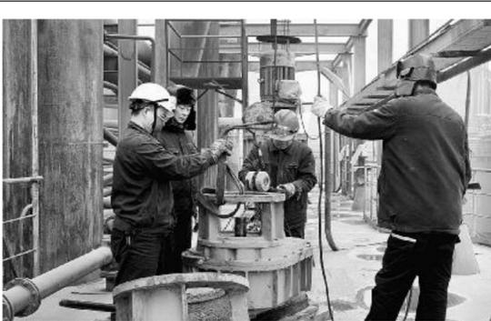
1月7日,正在运行的氧化铝厂脱鞋车间3'反应槽减速机出现噪音。为避免造成生产中断,该车间立即启动应急预案,并快速联系维修中心组织检修,保证了生产的稳定运行。图为该厂员工正在紧张检修。刘书文摄
