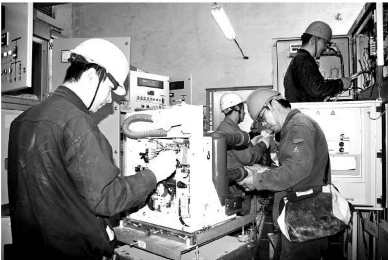
近日,氧化铝厂电气秋检工作正式展开。为确保工作顺利进行,该厂组织生产骨干对此秋检方案进行精心策划,对去年秋检过程中发现的问题进行分类汇总,从技术管理、设备装置、人员行为三方面明确每个专业、每个区域的薄弱环节、需要注意的重点问题及改进对策。不但列出了本次秋检区域的重点检查项目、检查内容,还为每个专业列出了详尽的
