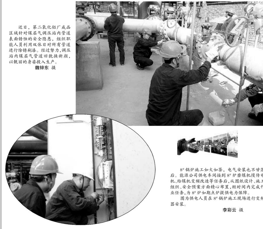
近日,第二氧化铝厂成品区域针对煤层气调压站内管道表面锈蚀的安全隐患,组织职能人员利用双休日对所有管道进行除锈刷漆。经过努力,调压站内煤层气管道旧貌换新颜,以靓丽的身姿投入生产。魏铎东 摄
