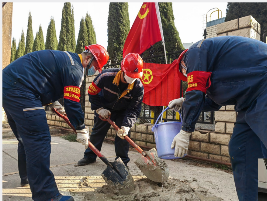
▲近日,云铝阳宗海动力党支部第一党小组组织党员、团员开展“文明创建我助力 美化环境我先行”主题党日活动,党员们化身“泥水匠”,拌砂浆、铺砖块,通力配合换来220千伏2号站路面焕然一新,为“全国文明单位”创建再添新亮点。图为活动现场。 温 静 张志会 摄影报道
