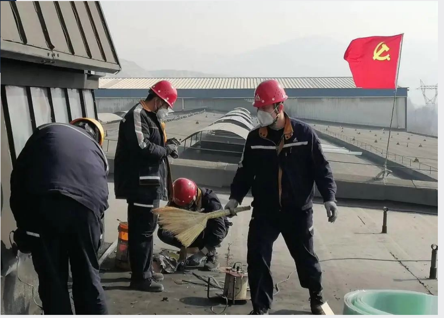
►近日,兰州铝业机修一厂党总支开展“亮化组装”主题党日活动,充分发挥党员先锋模范作用,更换组装作业区厂房采光板,为一线职工创造了干净、敞亮的工作环境,得到大家的一致好评。图为主题党日活动现场。 陈立飞 摄影报道
