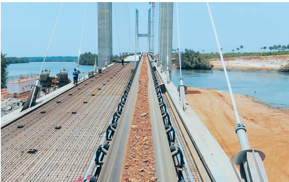
▲图为满载矿石的皮带穿过雄伟的法塔端拉河斜拉桥。
