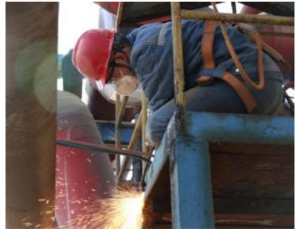
根据公司相关工作安排,为节约新水用量,近期,热电厂联合精细氧化铝大力实施水管改造项目,主要目的是将精细氧化铝工业水、冷却水进至热电厂燃化工区化学盘式过滤器,进入化学制水流程,减少燃化工区新水用量,该项目全部采用废旧管道,约1500米,改造后,预计每小时可以节约新水150吨。
