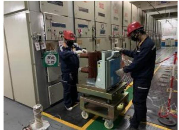
为确保电气设备安全、平稳度夏,近日,动力厂供电车间组织检修人员对电气系统进行春检,进一步掌握设备劣化倾向,提高设备本质安全。图为动力厂供电车间检修人员正在对中心配开关柜实施预防性试验。摄影报道 冉月蛟 姜涛
