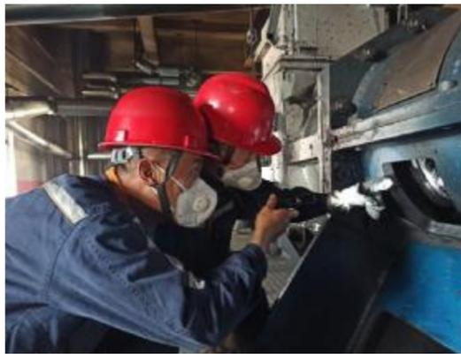
炭素事业部成型一车间党支部坚持“多调整、勤紧固”的设备管理思路，组织设备技术骨干找准“细、小、微”故障苗头，及时精准调整、清洗疏通、紧固处理，保障设备正常运行，有效提高了设备运转率。因为技术人员正在对连续混捏机轴承间隙进行监测、调整。
