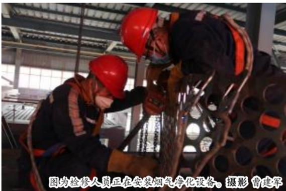
图为检修人员正在安装烟气净化设备。摄影 曹建军
