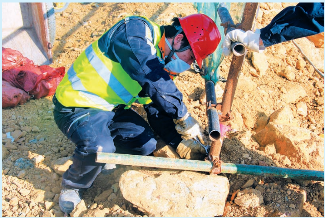
▲受疫情影响,云铝海鑫水电铝项目施工单位外地区员工不能按期复工,施工进度面临被延迟的困境。云铝海鑫不等不靠,及时从生产岗位抽调72名员工支援项目建设,协助施工方打通最先投入使用的开关站等项目关键节点,以“非常之功”力保项目早建成、早投产。图为该公司员工正在安装临时护栏。 王彦 摄影报道
