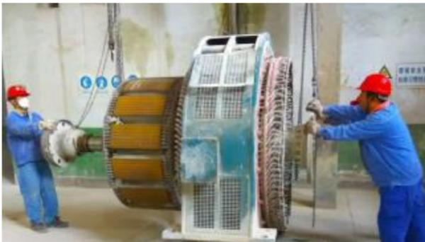
近日，山西中铝工服电气工程分公司完成第一氧化铝厂3号溶出磨同步电机的检修安装工作。参战员工克服现场蒸汽大、噪音大等不利因素，对电机的安装找正数据逐项核实，并对大罩吊耳重新更新焊接，经过两天不间断作业，终于完成检修任务，并一次试车成功。图为检修人员正在进行抽芯作业。摄影报道 郑向京
