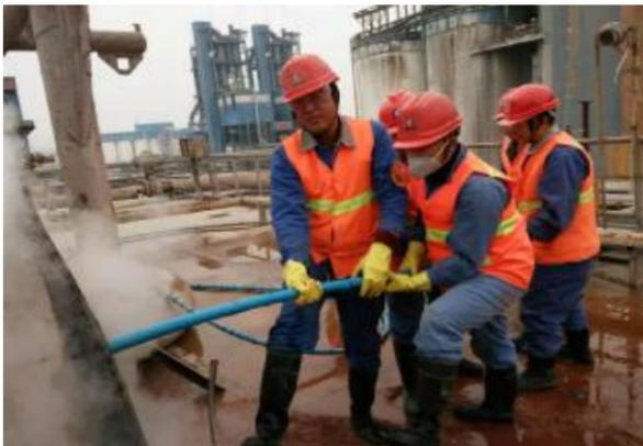
12月7日,山西中铝铝业专业清理分公司组织人员对第二氧化铝厂9号、10号精种管进行抢修清理。参战人员克服天气寒冷、高空作业等不利,采取两台清洗车两头同时向中间清洗的施工方式,经过9个小时的奋力抢修,终于在晚上19:00完成抢修疏通工作。摄影报道 景付昌
