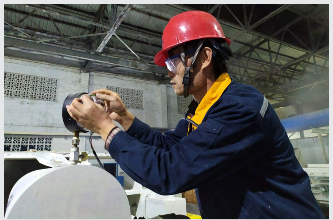
▲近期,中铝山东严抓安全管控,贯彻落实“冬季五防”工作预案,实施走动管理,查隐患,纠违章,加强设备点巡检,人人争当“安全卫士”,确保设备安全稳定运行。图为中铝山东氧化铝厂除杂工区压滤机岗位员工深夜巡检,查看4号车液压缸安全警示标识,及时更换粘贴标识标签。
