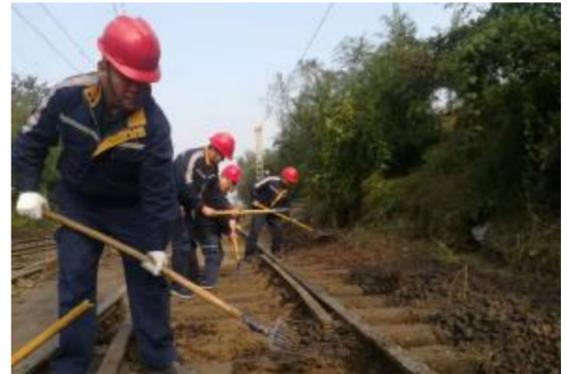
为改善运输线路状况,近日,物流运输事业部组织广大干部职工分区段对线路道床石砟进行清筛,通过规范清筛作业标准,道床回填做到石砟饱满、捣固密实,恢复了线路几何尺寸,提高了线路排水性能,提升了线路设备状况。截至目前,已完成300余空枕头清筛工作。图为员工正在进行清筛作业。
