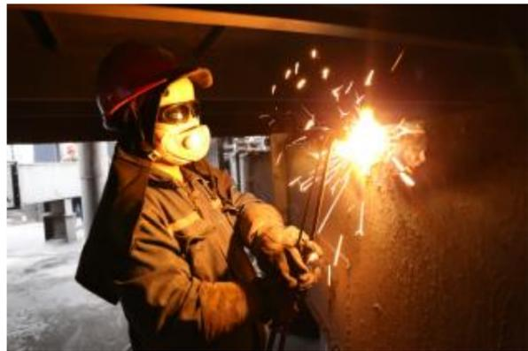
近期,热电厂分厂锅炉二工区利用停炉机会,对9号锅炉进行全面检修,包括平式过热器、水冷壁、风帽、焊接口、料床清理等大小项目40余项,并对水冷壁、率压部件低温段省煤器等部位进行重点检修。为确保检修质量,该工区安排专人负责,共更换平式过热器管7米,打磨补焊漏点360余个,检查风帽453个。图为检修人员正在补焊漏点。
