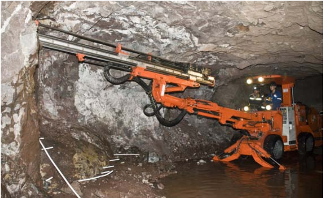
▲图为该公司猫场铝矿员工正在井下作业。
