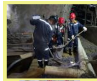
▼为防患于未然,提升矿井防水治水管理水平,有效预防水灾事故的发生。日前,矿业公司猫场铝矿组织员工对井底水仓进行清理。(易运红 摄)
