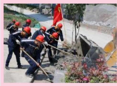
为提前做好防洪防汛工作,4月8日,在猫场铝矿书记、矿长的支持带领下,该矿党支部积极组织党员群众对猫场铝矿工业场地周边沟渠进行清理,确保了沟渠的畅通。(陈学林 摄)
