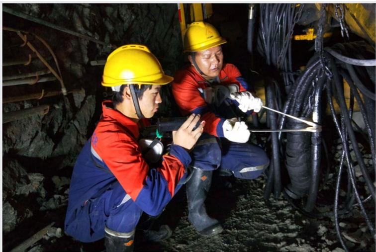
▲近日,云铝股份五溪矿业将安全作为企业一切工作的基础和条件,在安全生产中动真碰硬,向急难险重任务开战,以坚定的信心坚决打赢安全环保质量攻坚战。图为该公司员工正在检修井下雷岩台车油泵管道,确保安全生产。石燕梅 摄影报道
