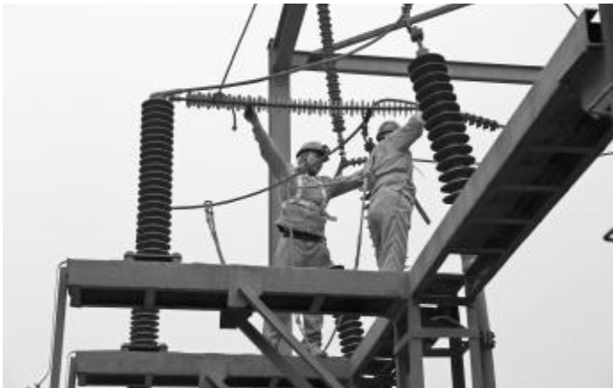
为确保春检工作安全有序进行，日前，热电分厂电气工区在做好春检动员的基础上，组织岗位人员认真学习安全规程、标准化操作规程，全员考试合格率达 100%。针对春检项目全、质量要求高的特点，专人现场监督把关，严格落实旁站监督，扎实推进新系统 1 号主变，更换绝缘子、瓷瓶套管清洗、紧固润滑试验、保护装置试验等项目。图为检修人员正在更换 1 号主变绝缘子。摄影报道 崔丽娜 王春伟
