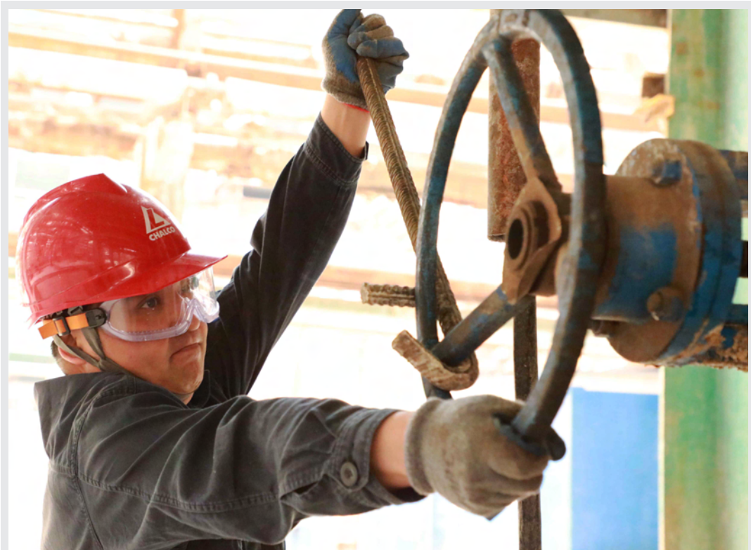
▲日前,中州铝业在安全环保质量攻坚战中进一步提升责任意识和担当精神,深入开展全面、全方位、全领域的地毯式隐患排查和整改活动,切实提高本质安全水平。图为该企业员工正在切断物料,便于检修工作安全进行。 洪卫忠 摄影报道
