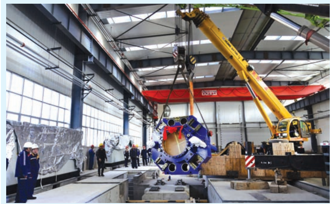
▲近日，西北铝特种行业铝合金材料产业化项目36MN挤压机前横梁正式吊装就位。该项目建成后将满足航空航天、军工、石油地质等行业对高性能铝合金挤压材的需求，形成特种行业用铝合金挤压材产业化规模。图为36MN挤压机吊装现场。
