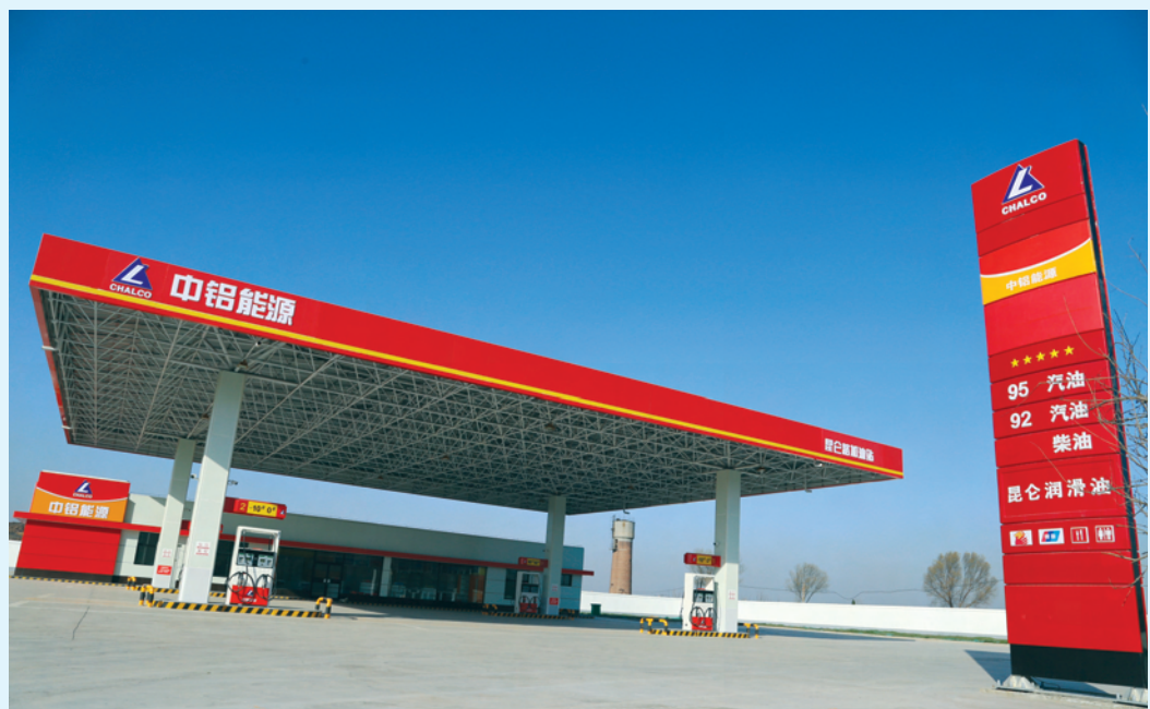
▲近日,河南中铝国储能源有限公司昆仑路加油站正式开业,标志着中铝物流中部陆港战略发展布局、市场开拓开启了新篇章。据悉,河南中铝国储能源有限公司是由中铝物流、长城铝业共同出资成立的合资公司。该公司昆仑路加油站是中国(郑州)有色金属国际物流港的重要基础设施,是国家二级标准加油站,开业后将实现对社会用户加油。图为新开业的加油站。
