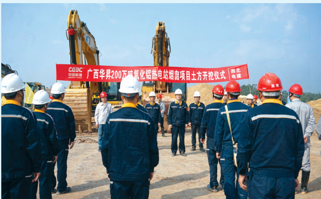
▲2月20日,广西华昇举行200万吨氧化铝热电站烟囱项目土方开挖仪式,标志着广西华昇新材料有限公司主体工程正式开工。图为开工现场。黄永按 潘欣 摄影报道
