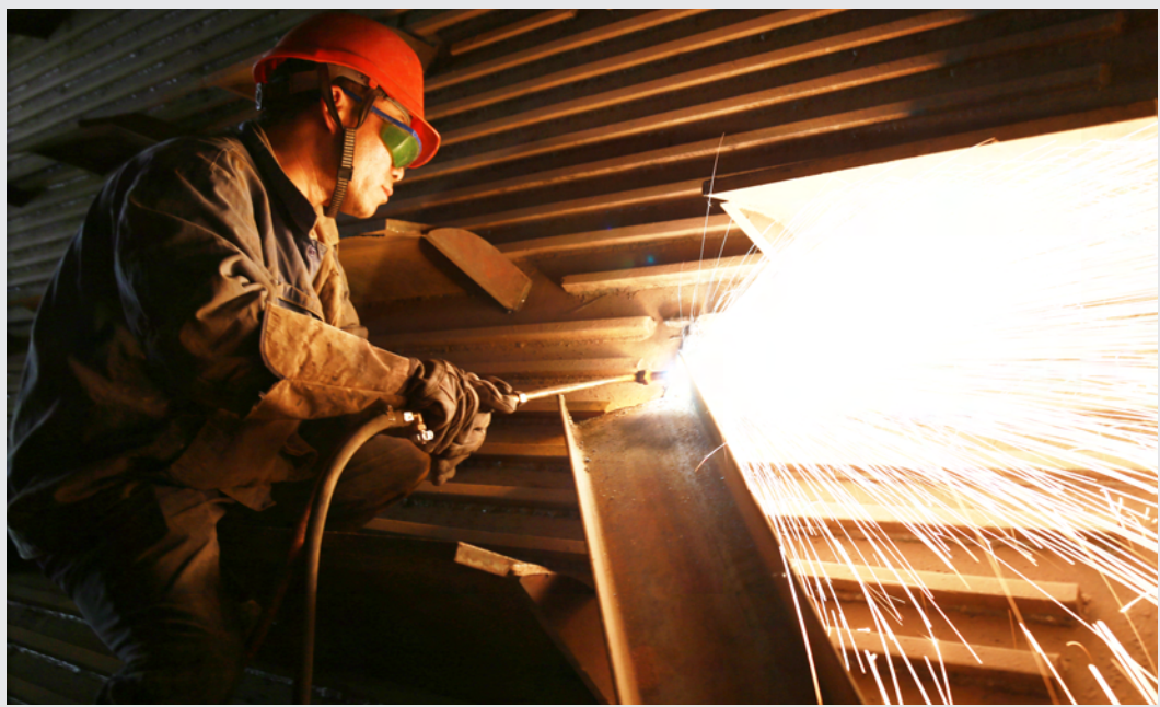
▲近日,山西新材料第一氧化铝厂以“全覆盖、零容忍、严执法、重实效”为原则,开展安全隐患大排查活动,眼睛向内抓安全、排隐患,步步为营全面提升安全管理工作,使安全管理工作“最后一米”落实落地。图为该厂员工正在对破损的熟料窑扬料板进行切割、更换,防止破损扬料板掉落伤人。张利 摄影报道
