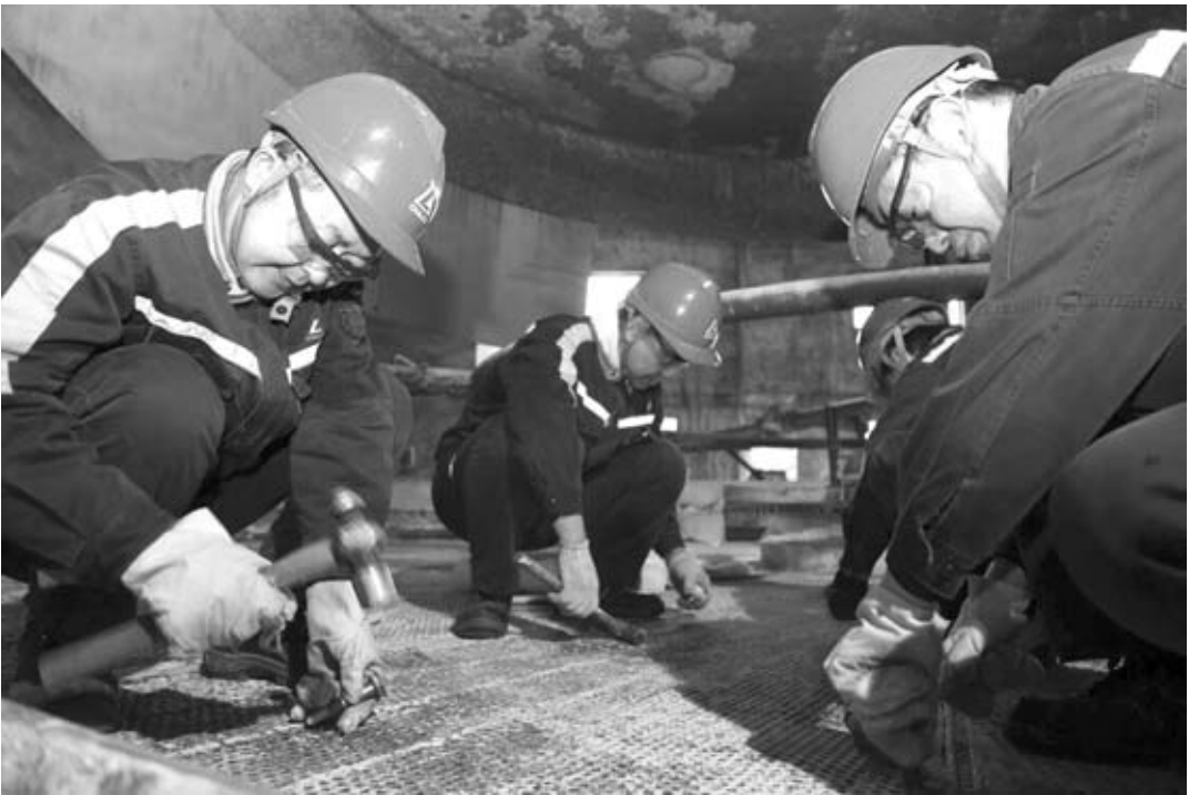
▲中铝集团2019年工作会议结束后,中铝山西新材料有限公司迅速贯彻落实会议精神,按照“低成本、高质量、机制优、效益好”的工作要求,紧盯全年目标,层层分解任务,制订详细措施,狠抓工作落实,为完成全年目标任务开好头起好步。图为该公司员工正在疏通平盘滤孔,确保生产安全平稳运行。 田小珍 张利 摄影报道
