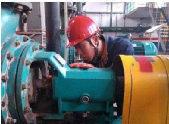
近日，动力厂持续开展“浪费辨识及整改”活动。自元月份以来，广大员工在日常工作中共发现浪费点17处，整改15处，节约费用6000多元。图为该厂动力车间空压站循环水泵工正在处置2#循环水泵机封漏水浪费点。
