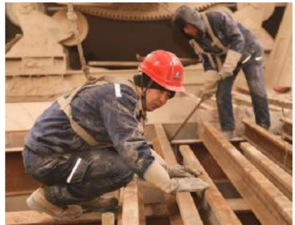
近日，第一氧化铝厂原料工区按照“应修必修，修必修好”的检修原则，组织专业维检人员对因冻块导致的翻车机仓篦子损坏部位进行修复。
