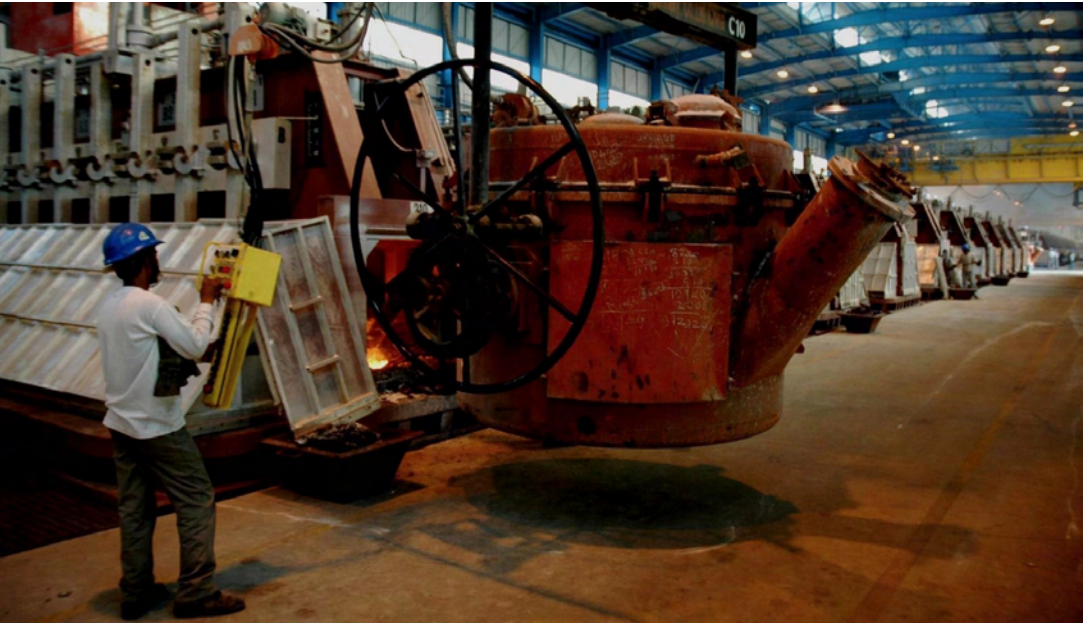
▲图为中铝国际承建的委内瑞拉电解铝作业现场。
