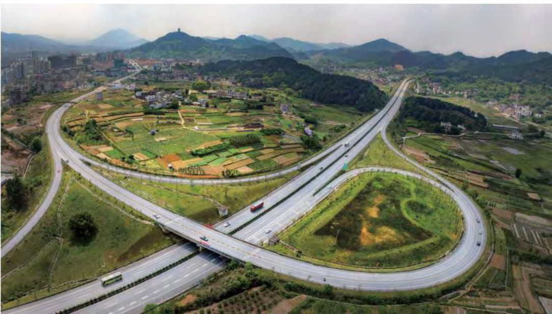
▲图为中铝国际承建的贵州都匀公路项目。
