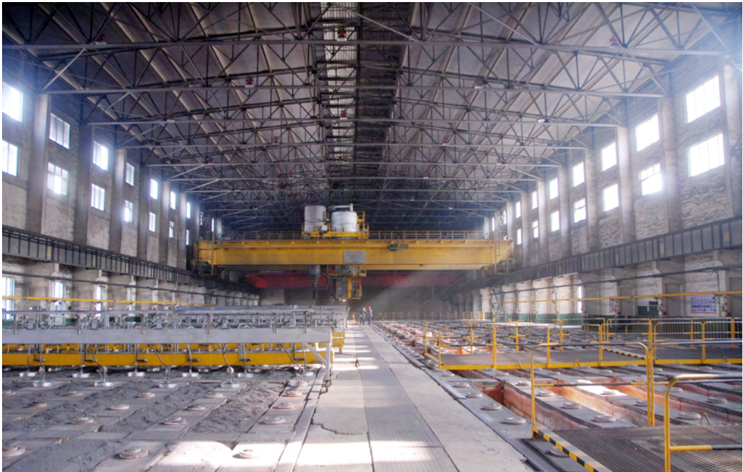
▲抚顺铝业新炭素项目建设现场。
