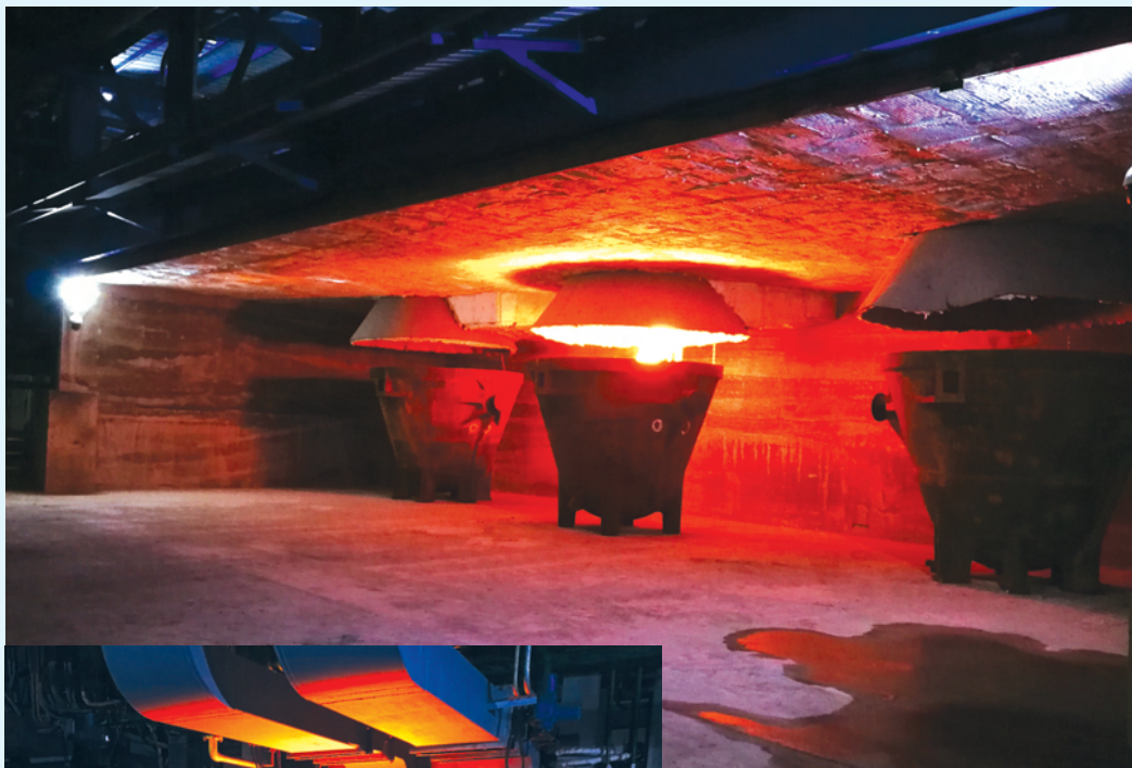
▲9月2日，东南铜业宁德40万吨铜冶炼基地项目经过前期原料干燥系统投料生产和各子系统升温调整，熔炼炉顺利投料并产出冰铜，标志着该项目实现一次性投料试车成功。
