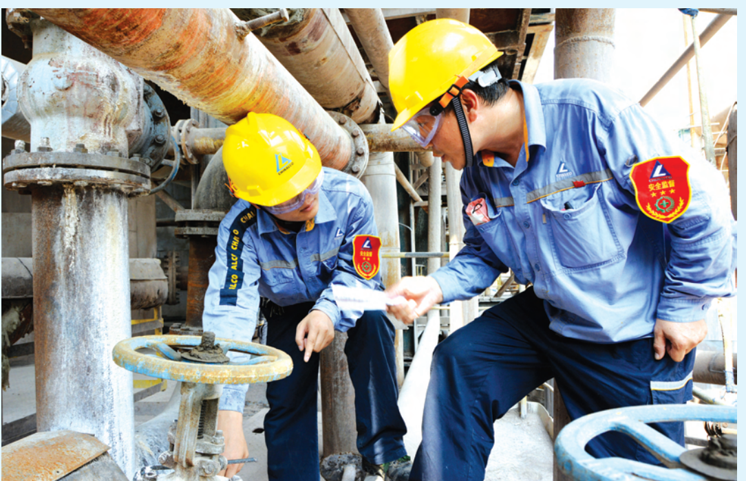
▲为确保酷暑天气清理检修作业万无一失，中州铝业加大作业全过程、全流程现场安全管理力度。图为近日该企业第二氧化铝厂安全管理人员正在现场确认溶出机组检修过程中流程管路走向以及阀门是否按照要求关闭。 杨俊华 摄影报道
