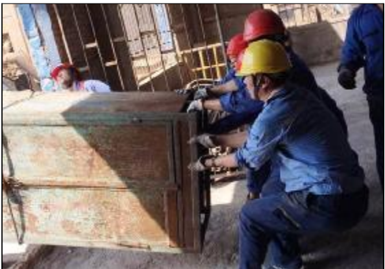
8月19日,山西中铝铝工服电气工程分公司抽调21名人员敷设电缆三百余米,设置配电柜四台,仅用半天时间完成了第一氧化铝厂熟料窑大修临时电源配套任务。摄影报道 郝向京
