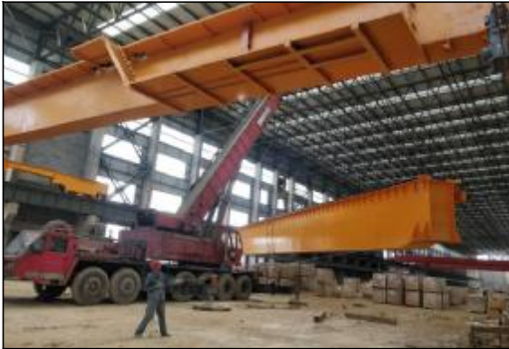
连日来,由华泽建安承担的电解板块焙烧多功能天车安装项目正紧锣密鼓推进,参战员工冒高温、战酷暑,狠抓项目安全、质量、进度,确保按期完工。摄影报道 吕建杰 郝启帆
