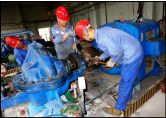
近日,山西中铝工服电气工程有限公司顺利完成热电分厂厂南泵房两台电机的倒换任务,解决了电机和机械的安装不匹配问题,提高了电机运行效率。图为员工在现场拆卸电机。
