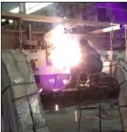
连日来,华泽建安干部员工紧盯电解槽大修不放松,连续奋战 80 多天,目前已高质量完成 34 台槽大修任务。图为电解槽集中大修现场。
