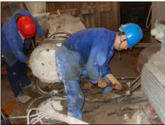
7 月 22 日,山西中铝铝工服电气工程分公司合理安排,员工加班加点奔波于各检修现场,一天内完成七项电机更换抢修任务,创该公司单日检修更换工作记录。 摄影报道 郑向京 丁庆江
