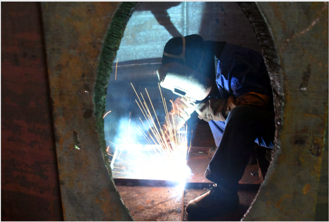
▲进入盛夏时节,气温大幅度提升,贵铝工服员工仍坚守在一线工作岗位上,认真重复着每天的焊接作业,为企业发展作着自己的贡献。图为该公司员工正在金属罐内焊接。
