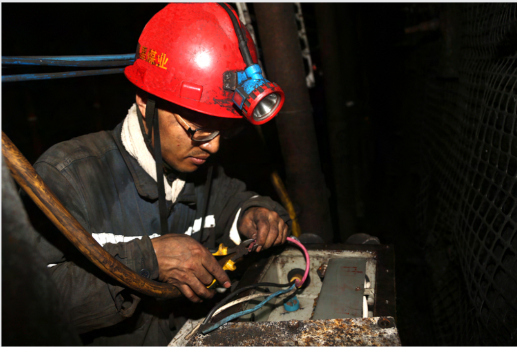
▲近日,宁夏能源银星煤业深入贯彻落实标准化“创一流”工作方案,着力提升员工在现场操作过程中的规范化、标准化,全面提升员工的安全行为意识。图为该公司员工在井下进行隔爆开关接线工作。 朱 增 摄影报道
