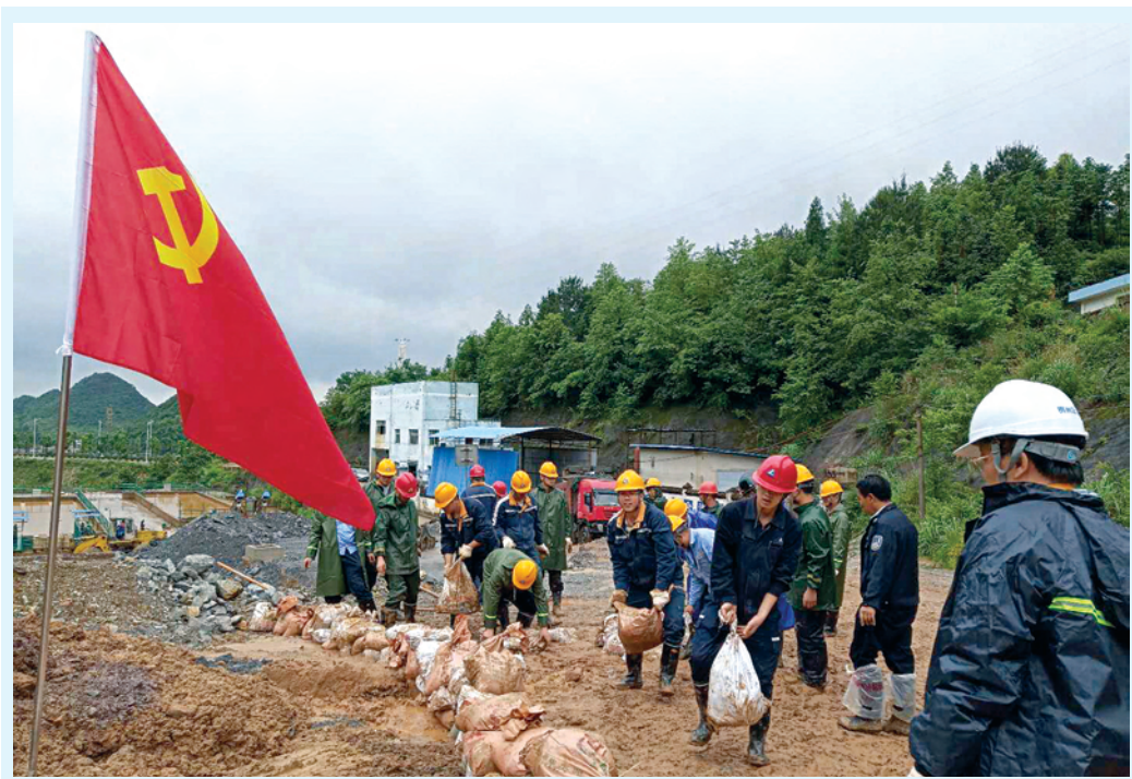
▲连日来,贵阳地区大雨频繁,导致中国铝业贵州分公司矿业公司麦坝铝矿水渠多处滑坡、地表水大量汇集。面对险情,贵州分公司矿业公司机关和麦坝铝矿的党员、入党积极分子和员工组成突击队,随时待命,及时处置险情,确保矿区生产不受影响。图为突击队正在组织防汛抢险。
