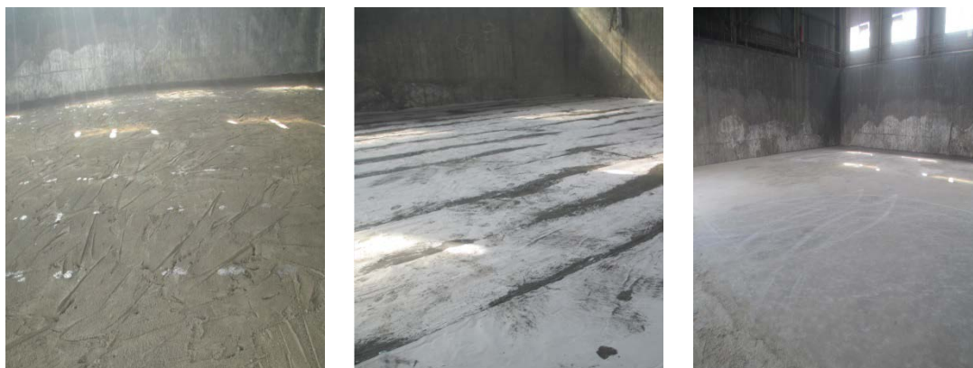
图 2-1 原料贮存及生产区域、无害化废渣贮存区防渗施工
