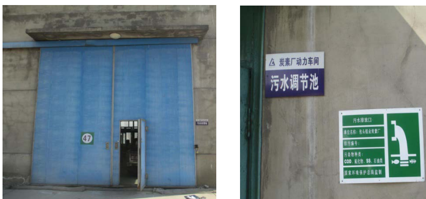
图 3-1 西区污水处理站
