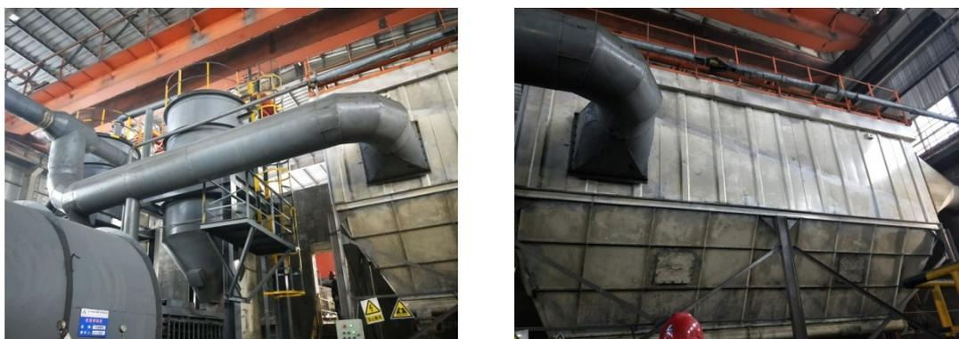
图 4-1 破碎废气净化系统
