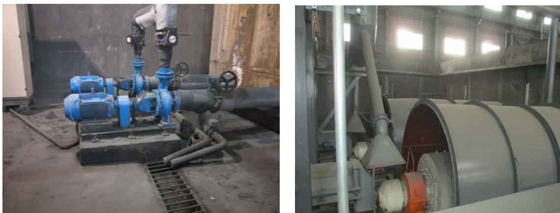
图 4-8 球磨机、泵基础减振、隔声罩、厂房隔声
