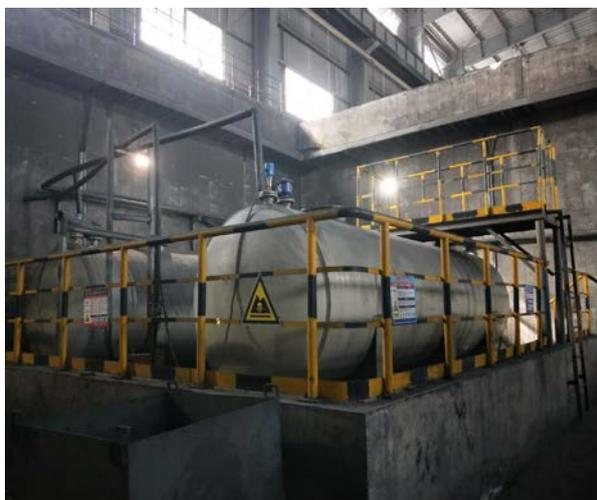
图 4-10 酸储罐及围堰
