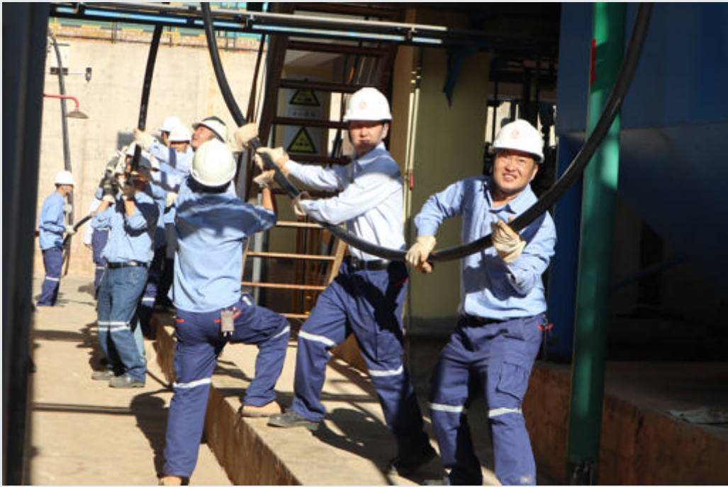
▲近日，根据中铝公司、中国铜业两级公司行动方案，滇中有色金属公司成立安全环保质量专项活动领导小组，及时、全面开展“全面大动员、全面大清查、全面大整改”强基固本专项行动，有序推进各项工作，为实现全年工作目标夯实基础。图为该公司干部员工在齐心协力放改电缆。 赵丽育 摄影报道
