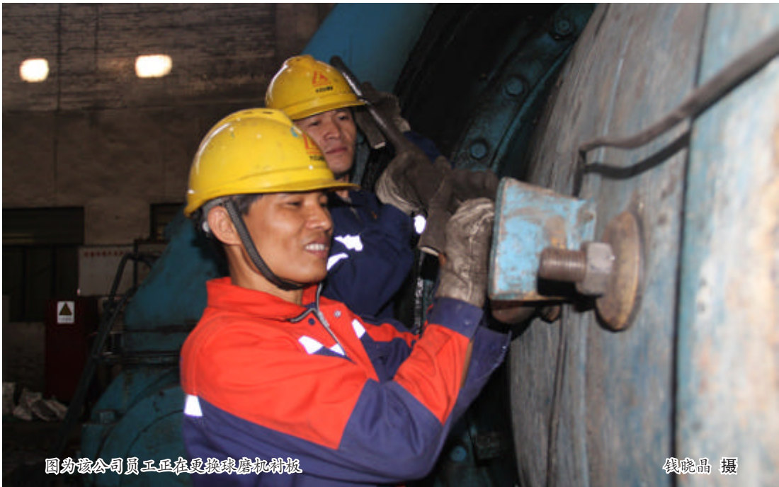
图为该公司员工正在更换球磨机衬板。
