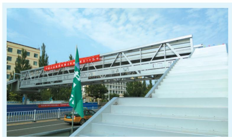
▲7月21日凌晨,由中铝国际铝业设计研究院有限公司总承包的呼和浩特特多斯街东大街大学铝合金人行天桥一次吊装就位,这是内蒙古自治区首座铝合金人行天桥,也是中铝公司承建造成的第一座铝合金人行天桥。该天桥的设计采用了结构外露的手法,镂空的桁架使桥体显得轻盈通透,桥身处提取了内蒙古的建筑文化元素,融入了特有的云纹,使其凸显地方文化特色,与周边环境相协调。该人行天桥跨度33米,桥宽约3.4米,桥上行人通行净空间可达3.0米,桥下机动车通行净空间可达5.0米。天桥有两个上下楼梯及两部自动扶梯,方便行人通行。项目建成后,将大大改善该路段的交通状况。(刘峰)
