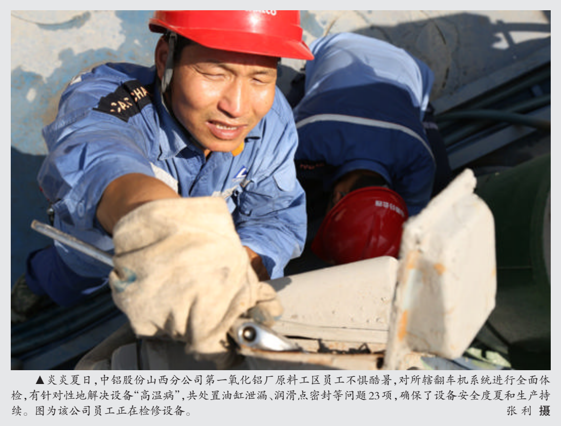
▲炎炎夏日,中铝股份山西分公司第一氧化铝厂原料工区员工不惧酷暑,对所辖翻车机系统进行全面体检,有针对性地解决设备“高温病”,共处置油缸泄漏、润滑点密封等问题23项,确保了设备安全度夏和生产持续。图为该公司员工正在检修设备。 张利 摄
