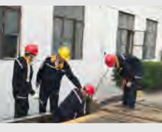
近日,质检中控中心党员带头开展“一降三提”主题实践活动,对公司两台电子汽车衡全面排查维护,同时对衡器底部全面清理,为秤体除锈刷漆,降低维护费用的同时保证了设备的稳定运行。
