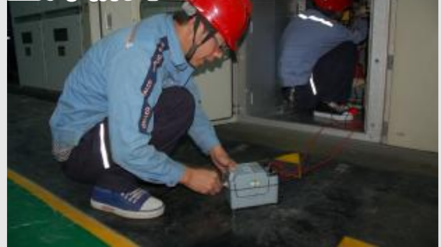
近日,能源动力厂供电车间组织运行人员对检修完的每台设备进行电缆绝缘测试,防止因电缆绝缘不合格送电造成相间、对地放电甚至放炮,确保人员设备、安全。
