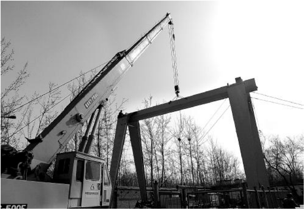
2月19日，中州铝建检修车间钢材区10T龙门吊恢复安装主体完工，后续附件安装、调试工作正在有序进行中。左图为龙门吊安装现场。 任少鹏 摄
