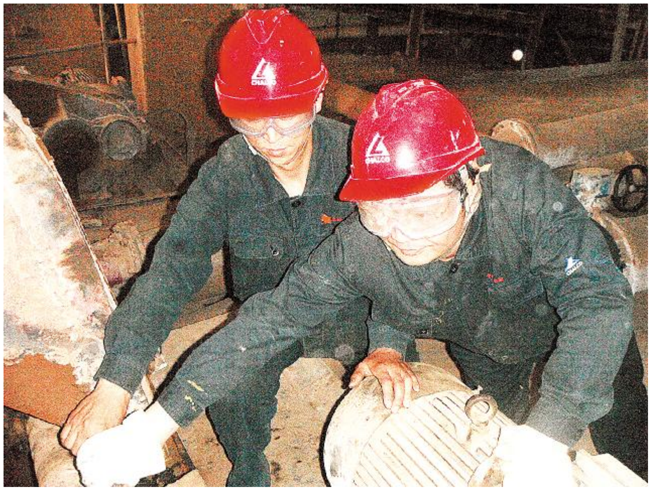
第二氧化铝厂沉降车间烧结工区积极开展党员技术攻关活动，以创新的思维寻求降本增效的新途径。在4#溶出磨检修期间，党员们主动修复溶出磨直齿轴轮异常运行情况，并在出水端大瓦外加装排水阀，便于员工随时观察设备润滑状况，确保设备安全稳定运行。图为党员正在现场紧固电机螺丝。 邢林群 摄
