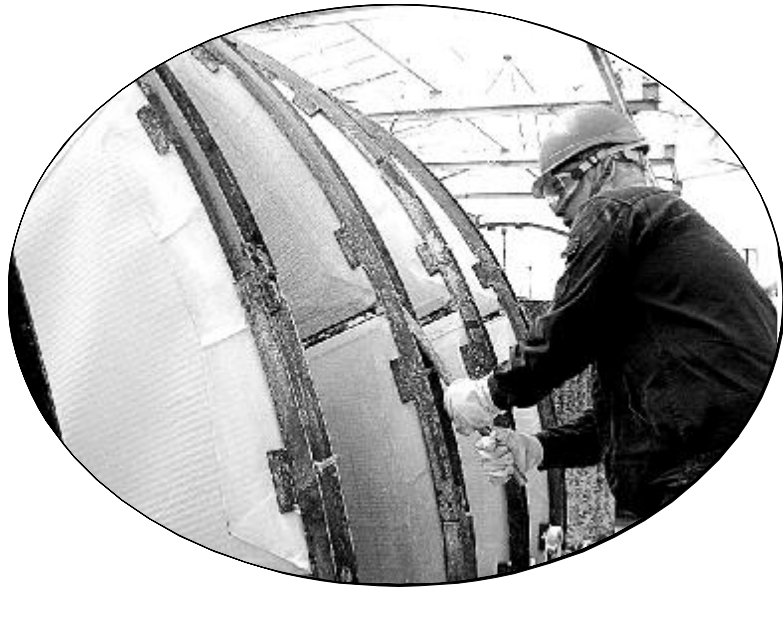
上图:6月18日,第二氧化铝厂成品车间3#焙烧炉电收尘完成大修。为响应国家环保号召和要求,今年,成品车间电收尘将逐台进行达标排放技术改造。此举,既能提升外排环保要求,又可以大大提高收尘效率,减少氧化铝损耗。图为3#焙烧炉电收尘即将封顶。 杨俊华 摄
