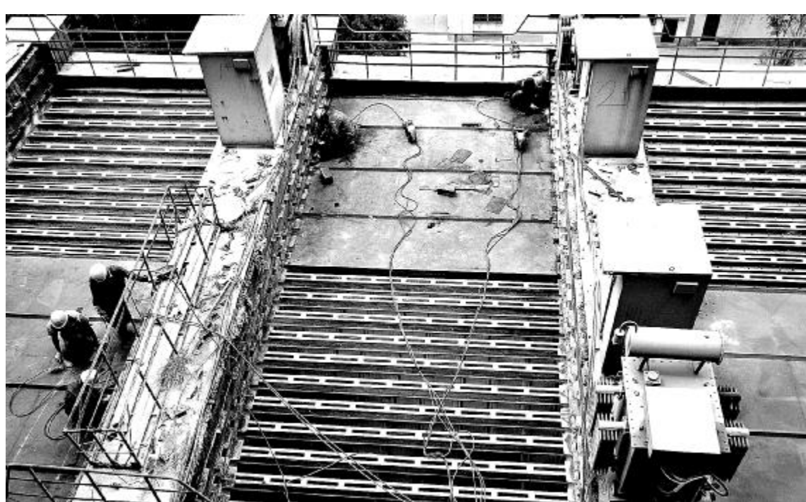
上图:6月18日,第二氧化铝厂成品车间3#焙烧炉电收尘完成大修。为响应国家环保号召和要求,今年,成品车间电收尘将逐台进行达标排放技术改造。此举,既能提升外排环保要求,又可以大大提高收尘效率,减少氧化铝损耗。图为3#焙烧炉电收尘即将封顶。 杨俊华 摄
