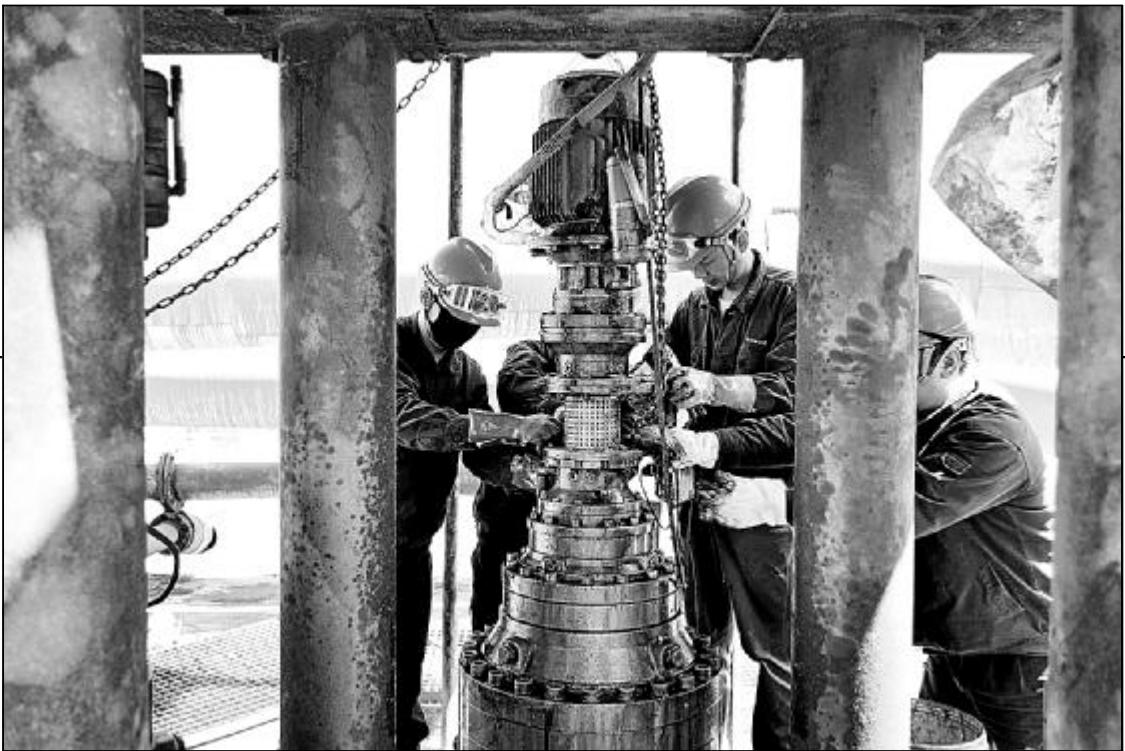
上图 5 月 11 日, 第二氧化铝厂综合车间接到沉降车间二线 1°分离槽耙机润滑油泄漏检修任务后, 立即行动, 快速处理, 拆检并更换磨损的耙机密封。图为大家正齐心协力检修设备。杨俊华 摄
