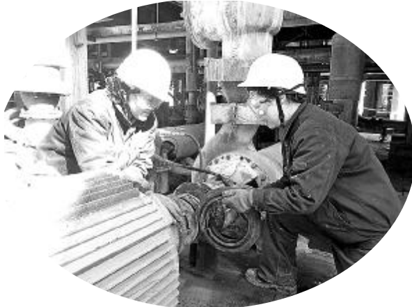
“三八”节前夕,第二氧化铝厂蒸发车间女工以“劳动光荣”迎来自己的节日。图为该车间女工在检查蒸发器过料系密封泄漏。 兰岚 摄
