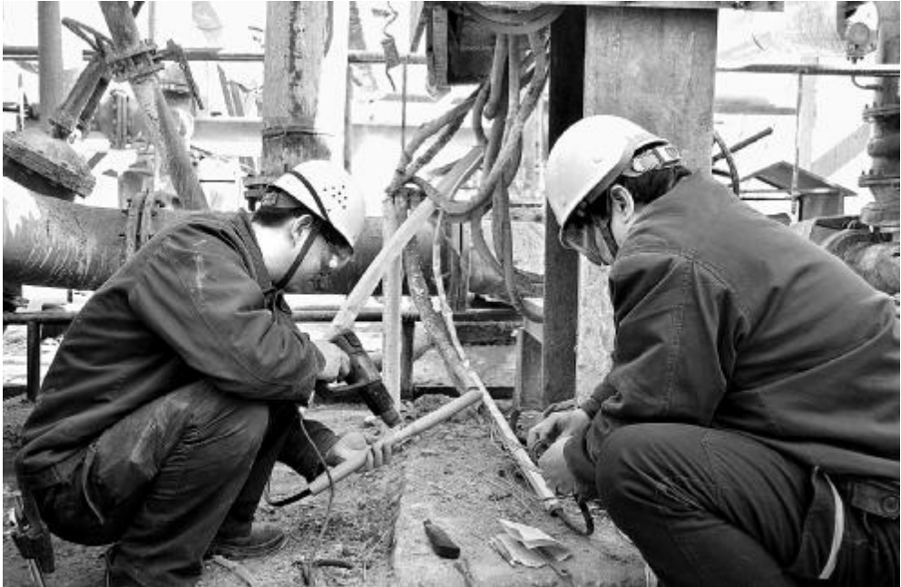
日前，第二氧化铝厂全面启动电气春检工作，在强化安全保障的同时，积极组织人员进行配电室和各类电器设备的检查、检修和维护保养。图为 3 月 3 日该厂沉降车间电器开关移位改造时，两位员工对接线头的情景。
