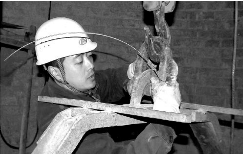
中州铝建土工车间在日前进行的 4 # 石灰炉内衬大修项目中，采用全方位排查安全隐患、制定突发事件预案、加强安全检查等方式，确保项目施工安全有序进行。图为作业人员正在检查吊装作业的安全防范措施。
