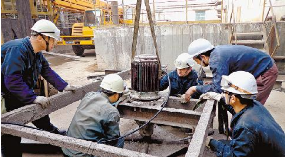
图为2月17日第二氧化铝厂成品车间电工班和钳工班齐心协力对冷却塔风机进行检修，保证了春节期间焙烧炉的稳定运行。魏铸东 摄
