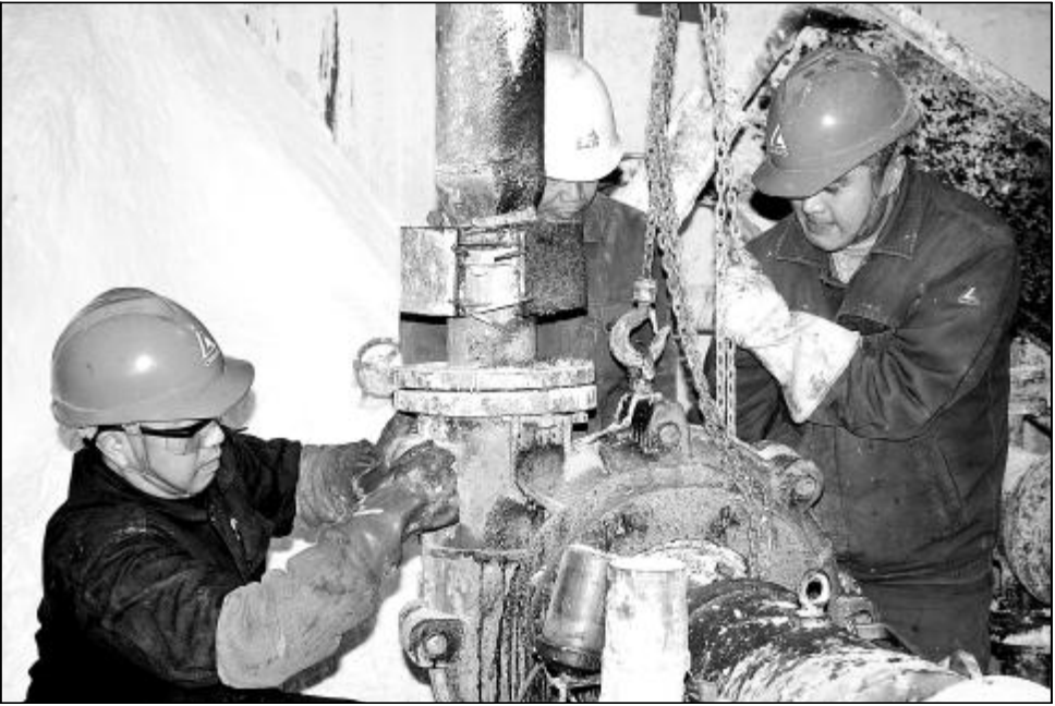
连日来，第二氧化铝厂成品车间深入开展“查碱治水”活动，针对 3 # 冷却塔风扇带走较多水蒸气造成浪费的现象，综合班利用 3 # 冷却塔停车清淤有利时机，对冷却塔风叶角度进行调整，减少软化水的浪费。图为综合班员工正在调整叶片。
