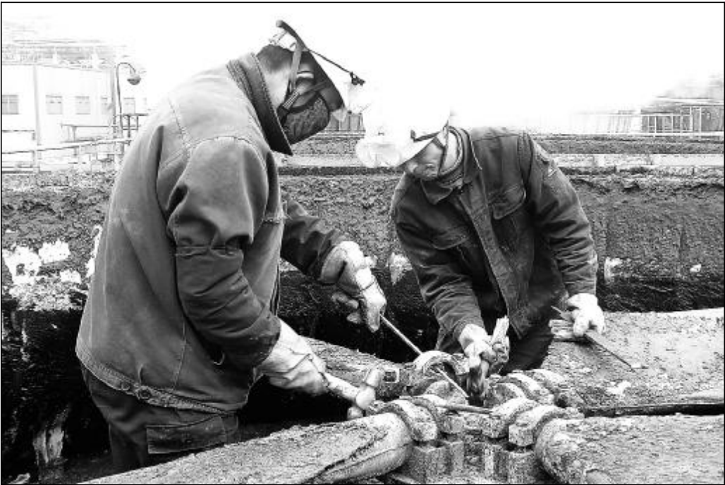
连日来，第二氧化铝厂成品车间深入开展“查碱治水”活动，针对 3 # 冷却塔风扇带走较多水蒸气造成浪费的现象，综合班利用 3 # 冷却塔停车清淤有利时机，对冷却塔风叶角度进行调整，减少软化水的浪费。图为综合班员工正在调整叶片。
