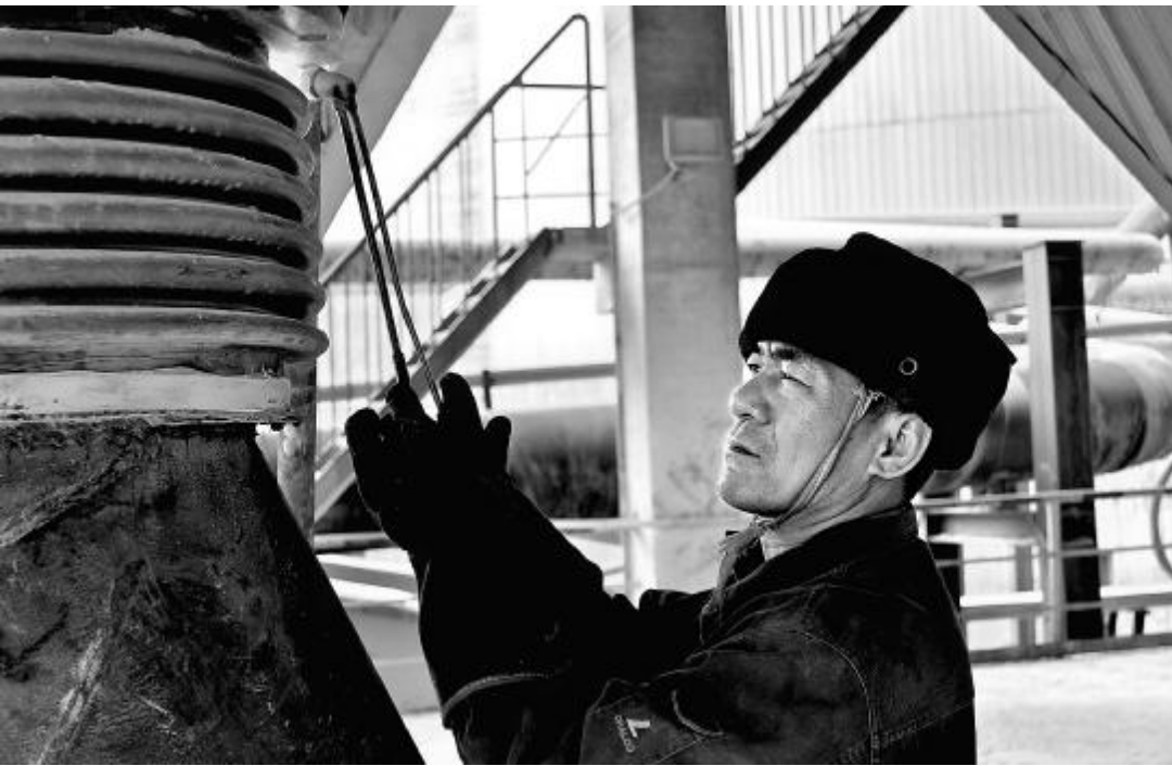
为保证元月份商品氧化铝高产组织的顺利运行，第二氧化铝厂成品车间积极组织检修，消除各台焙烧炉系统隐患，使每台炉于快速处在最佳状态。图为 1 月 14 日，5' 焙烧炉消缺工作进入攻坚阶段，检修人员正在更换收尘返灰系统的膨胀节。
